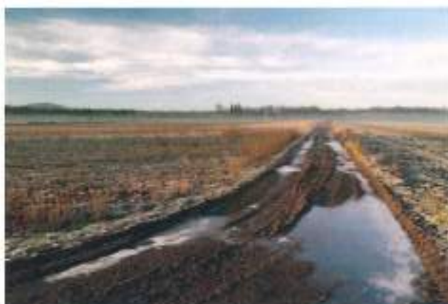
IMAGEN 12: EJEMPLO DE TERRACERIA CON UNA CALIDAD DE DRENAJE POBRE
